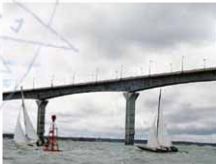
A virer la bouée Sud/Nord du Pont de Ré
